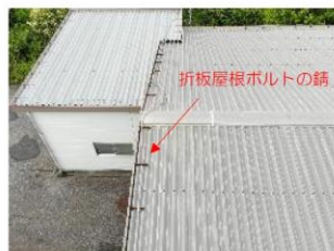
図 ドローン空撮画像による屋根劣化診断
