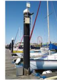
船橋に設置された「PCWL-0410」 IP67相当の防塵・防水性を備えているため 屋外でも安定した通信環境を提供
